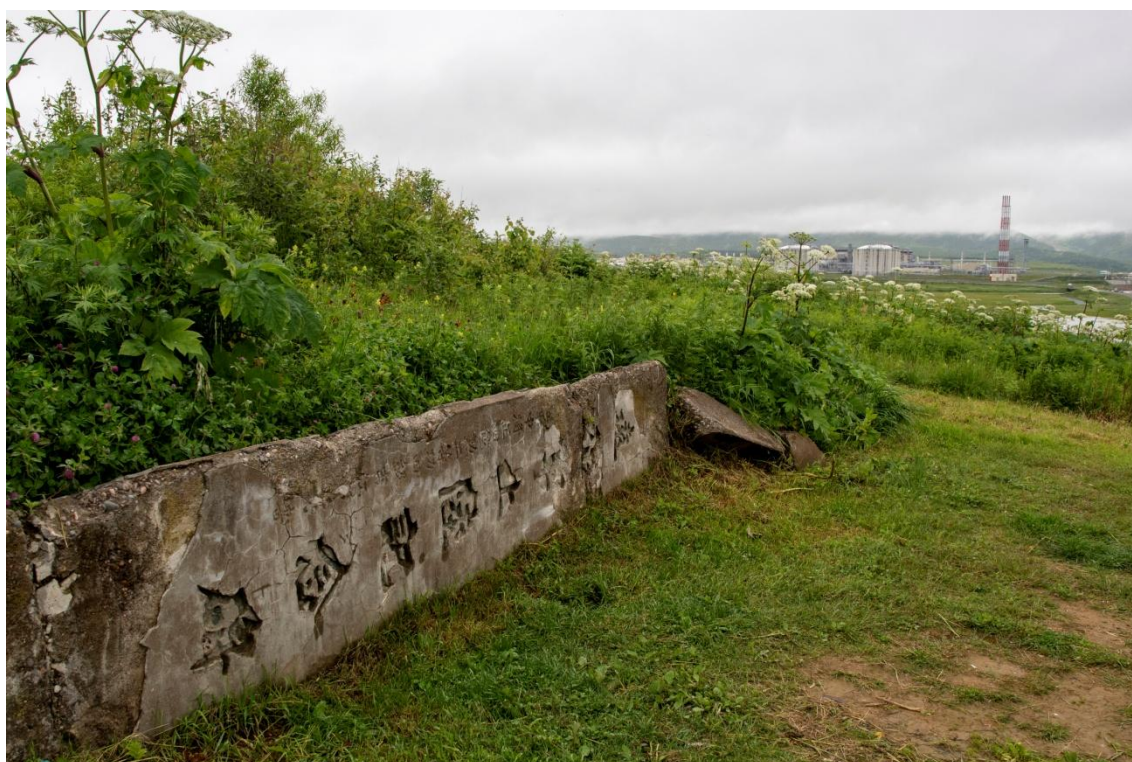
旧日本軍の上陸記念碑と奥はプリゴドノエの天然ガス液化プラント
