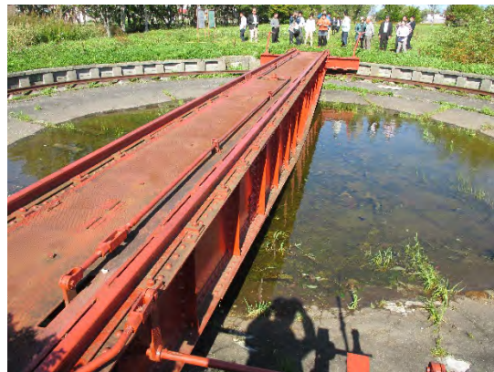
根室標津駅転車台
